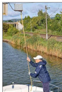
Une tirette manuelle permet aussi de déclencher l'éclusage, de Steinbourg à Hochfelden et au-delà.
