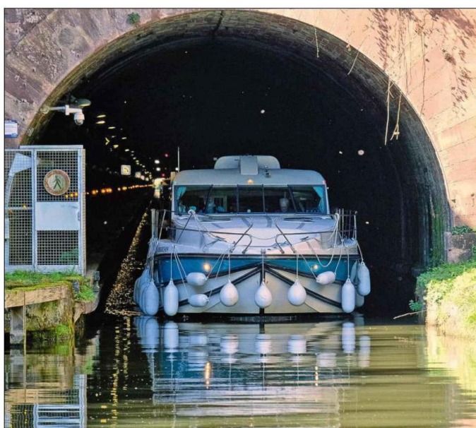
Les tunnels se franchissent sous le régime de l'alternat, régulé par des feux et des zones d'attente.
